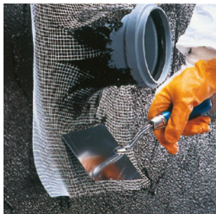
Einarbeiten in die erste Bitumenlage
