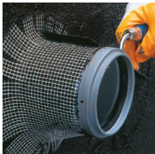
Überspachteln mit zweiter Bitumenlage
