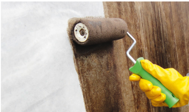
Aufrollen der Grundierung
