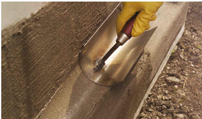
Mineralische Hohlkehle mit Rundkelle
