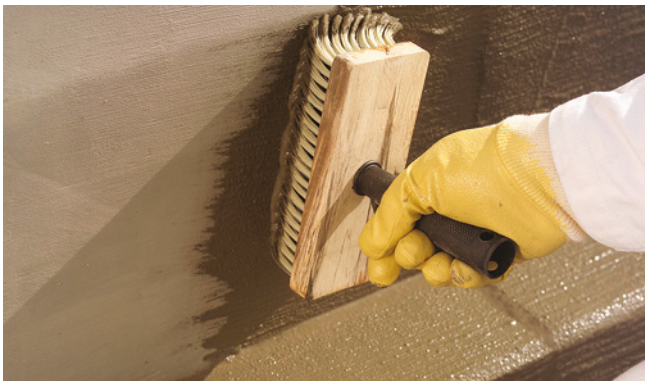
Dichtungsschlämme im Bankettbereich auftragen
